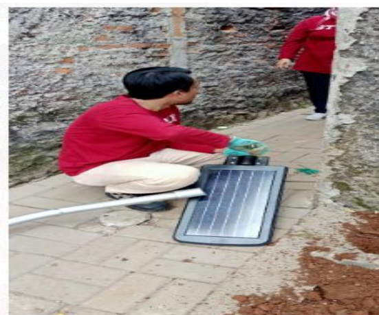
Gambar 8 Instalasi lampu dan solar panel
