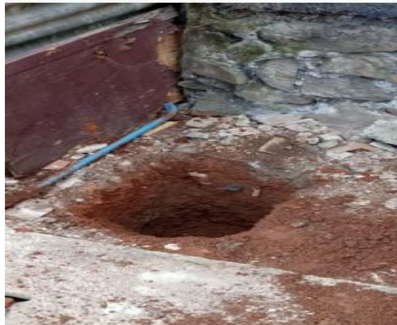
Gambar 7 Penggalian Lubang Pondasi Tiang
