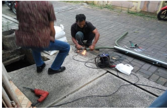
Gambar 6 Pemotongan dan Pengelasan Tiang.
